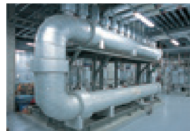
Система теплообмена, использующая тепло от электрического генератора, охлаждает оборудование для литья под давлением.
